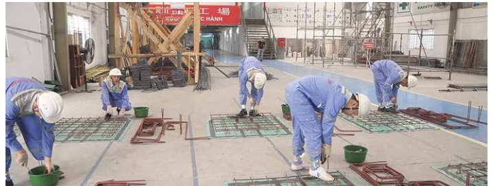
ベトナムでの鉄筋組立試験
