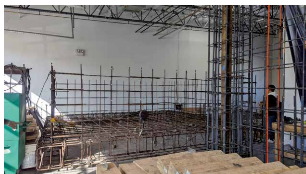
配筋(奥)とマスティンバーの組立(手前)を学べる設備
