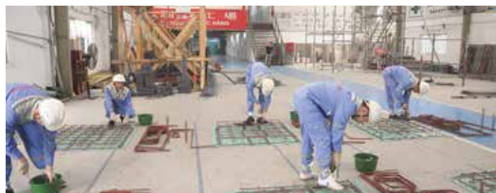
ベトナムでの鉄筋組立試験
