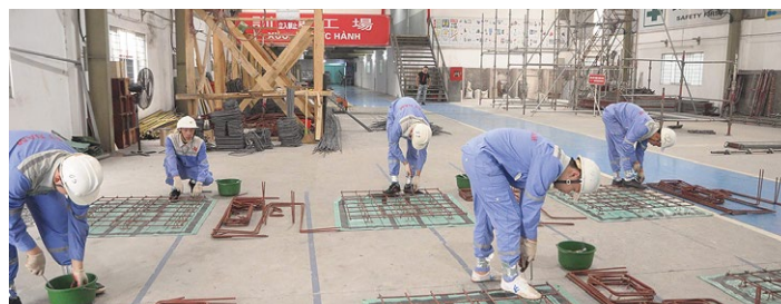
ベトナムでの鉄筋組立試験
