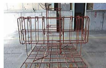
全鉄筋で準備した鉄筋組立教材
